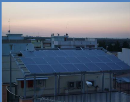
Impianto FV da 5,98 kWp Bitonto
