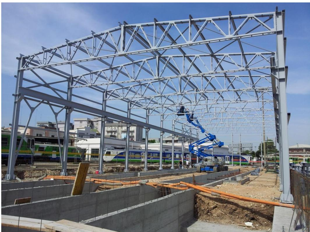
Adeguamento deposito officina Bari Scalo alle caratteristiche del nuovo materiale rotabile e realizzazione di nuovo capannone con struttura portante in acciaio da destinarsi a deposito officina per la manutenzione dei treni – Bari Scalo
